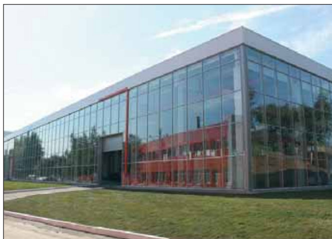
ООО "АЗУР": реконструкция Первоуральского металлургического колледжа
