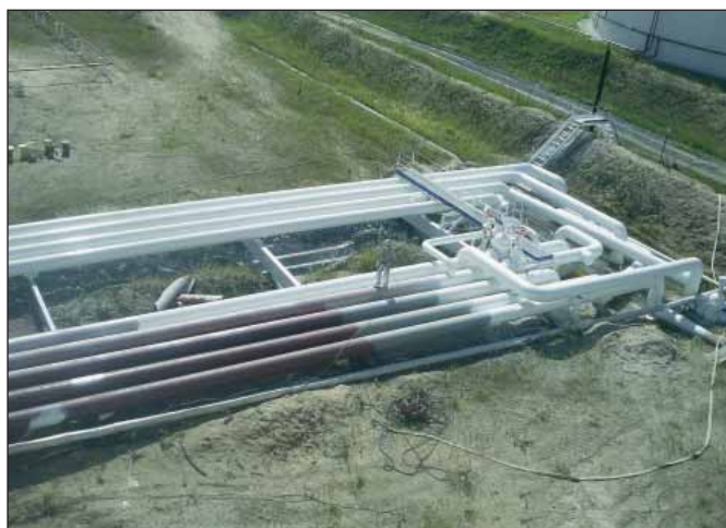
ООО АКО "Теплолюкс": АКЗ работы на трубопроводе Ново-Уренгойской ГРЭС
