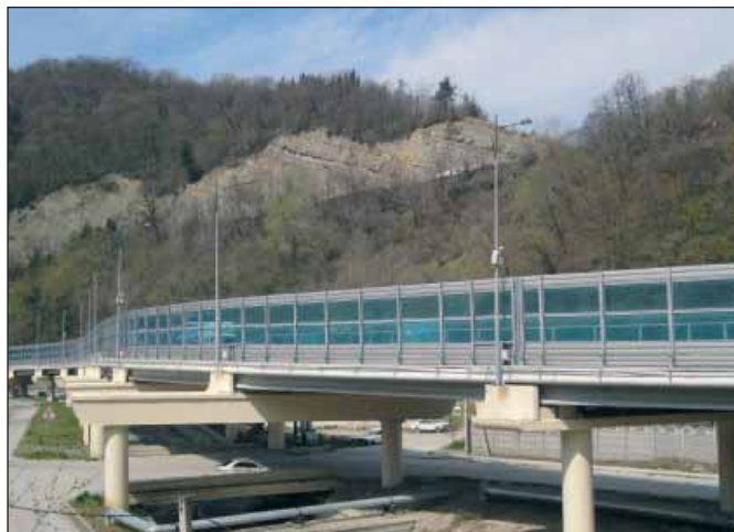
ЗАО НПХ ВМП: мост вдоль реки Псахе, г. Сочи - покрытие металлоконструкций и бетонных опор материалами ВМП
